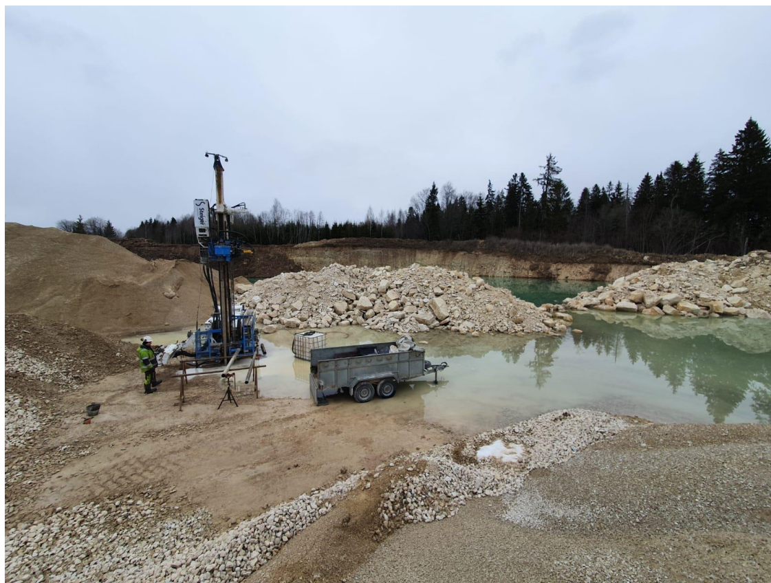
Foto 4.1. Lubjakivi puurimine puurpingiga Massenza MI8 (foto M. Peetris 18.04.2022; N 58°57'01" ja E 26°01'34").
